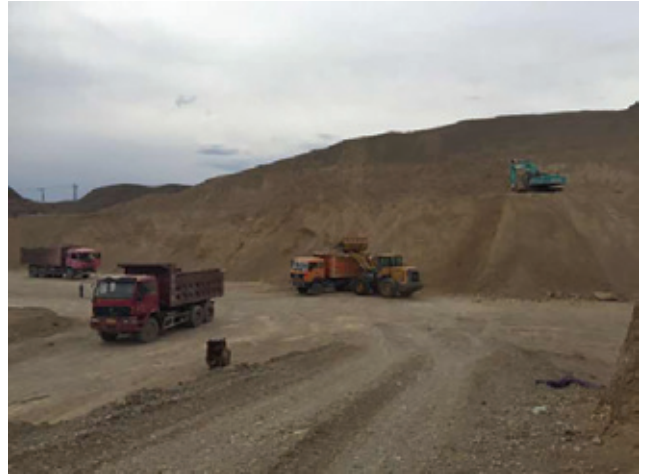
施工现场作业图(1)
