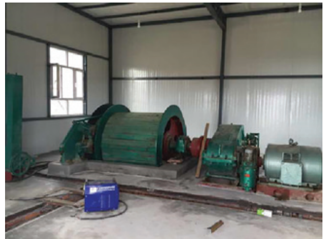
绞车系统安装
